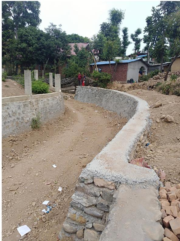
Ilustración 7: Muro de protección de riveras del cauce para proteger las viviendas por inundaciones. Birendranagar, Nepal.
